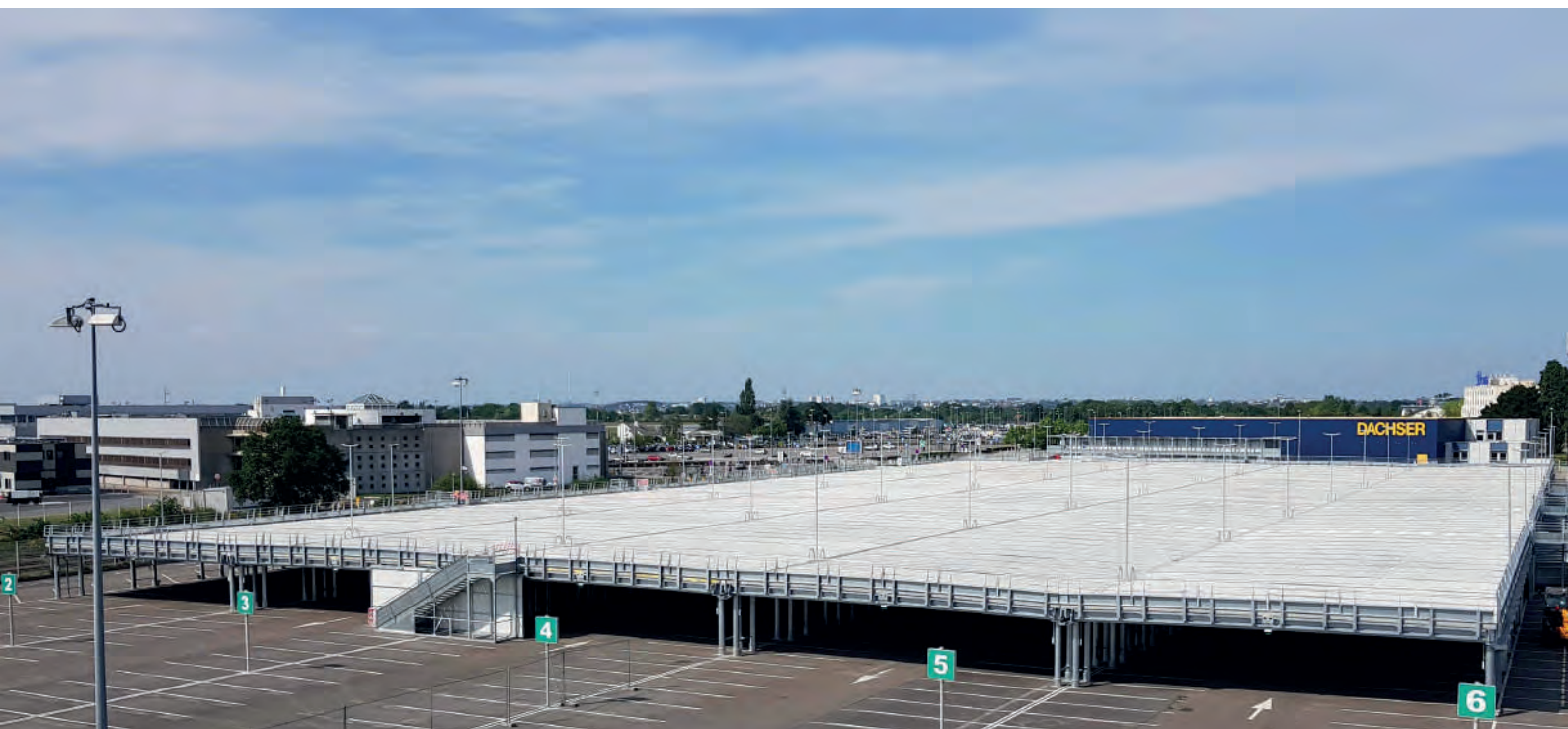
Nouveau parking silo « Park'up » de l'aéroport de Nantes (44) - Nextensia
